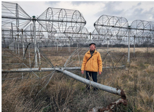
LE CHERCHEUR UKRAÏNENNE SIDORTCHOUK DÉCOUVRE DES ANTENNES ENDOMMAGÉES PAR LES TIRS RUSSÉS. © ERIC LUSITO
